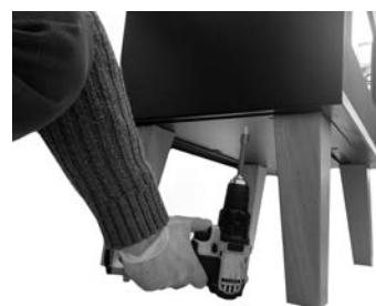
Fig. 31 - Fijación de la estufa
